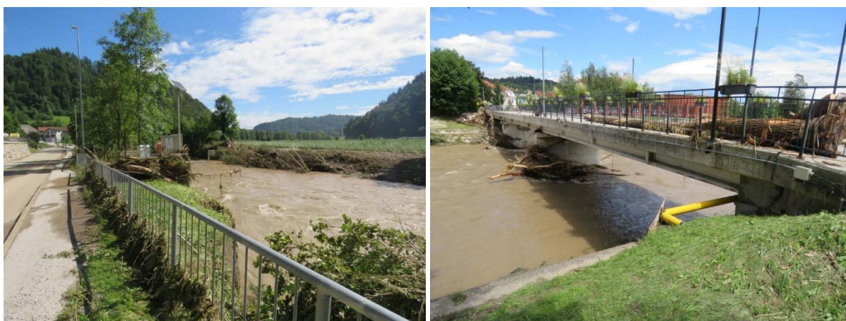
Slika 14. Poplavne sledi na vodomerni postaji Zminec na Poljanski Sori (levo), in na mostu dolvodno od vodomerne postaje Medvode na Sori (desno), 8. avgusta 2023 (vir: arhiv ARSO).
