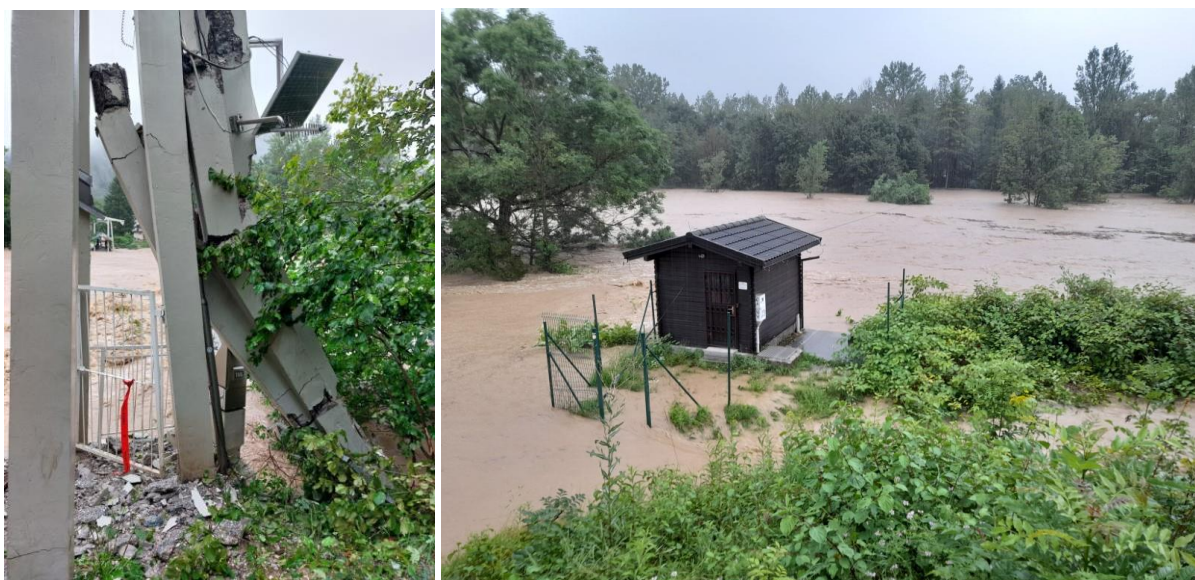
Slika 16. Uničena brv ob vodomerni postaji Medno na Savi (levo), 4. avgusta 2023, in vodomerna postaja Šentjakob na Savi (desno), neposredno pred preplavitvijo 4. avgusta 2023 (vir: arhiv ARSO).
