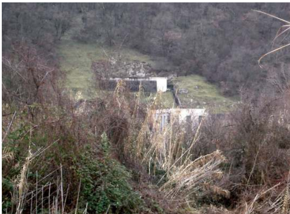
Slika 2. Črpališče podzemne vode Gabrijeli Figure 2. Gabrijeli groundwater caption
