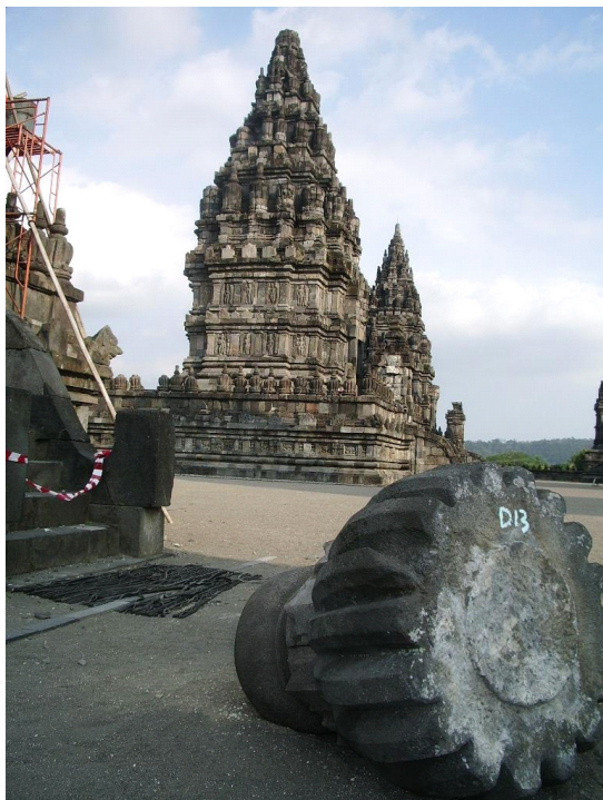
Slika 5. Podrt stebler v templju Prambanan, ki sodi med največje in najlepše hindujske tempelje v Indoneziji Figure 5. Collapsed tower of Prambanan temple, one of the biggest and most beautiful hindu temples
